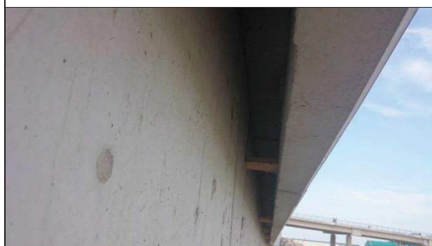
Foto. 3 Dištančné kolíky pod rímsami
