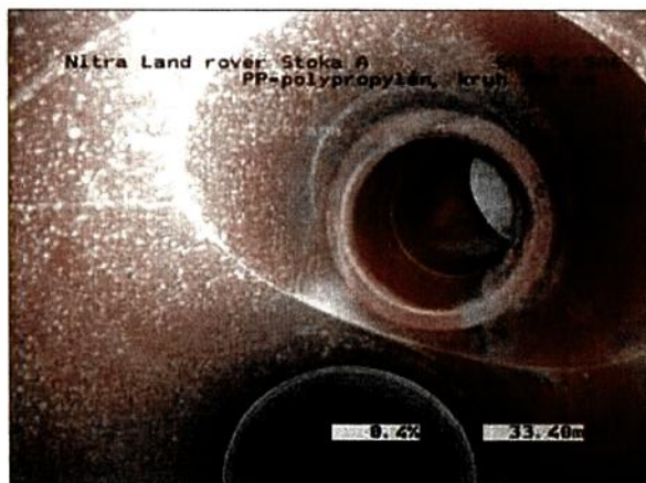
Foto: 68_2a 33,4m, Prípojka, pravá strana
