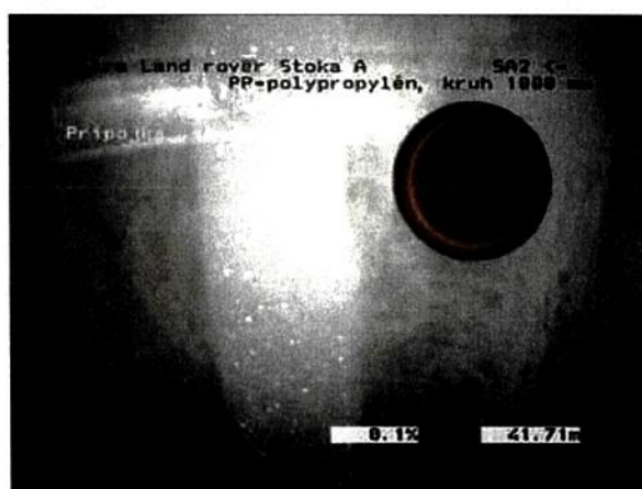
Foto: 77_4a 41,71m, Prípojka, strop
