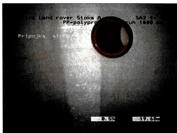
Foto: 75_2a 19,6m, Prípojka, strop
