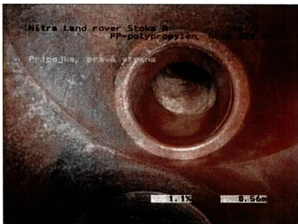
Foto: 65_1a 8,56m, Prípojka, pravá strana
