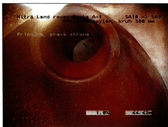
Foto: 91_4a 44,42m, Prípojka, pravá strana
