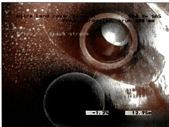
Foto: 63_1a 12,95m, Prípojka, pravá strana
