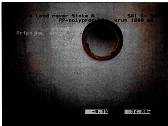
Foto: 57_1a 34,8m, Prípojka, strop
