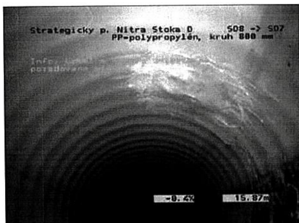
Foto: 6_1a 15,87m, Info: Lokálna oprava umiestnená na pozadované miesto
