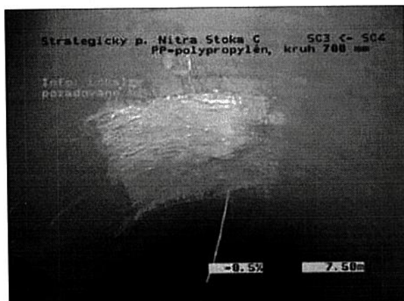
Foto: 2_1a 7,5m, Info: Lokálna oprava umiestnená na pozadované miesto
